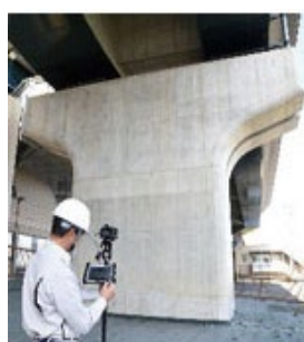
AIひび割れ解析 ソリューション
